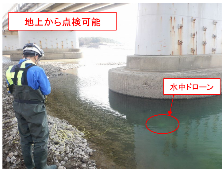
写真-1 点検状況
