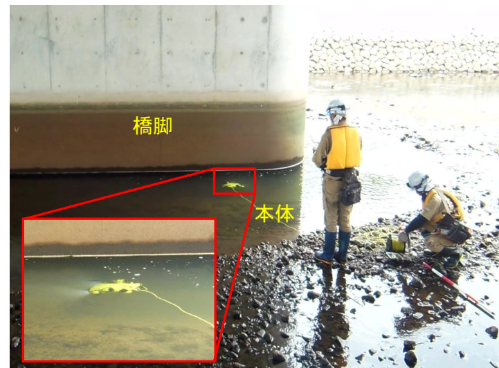
写真-2 点検状況
