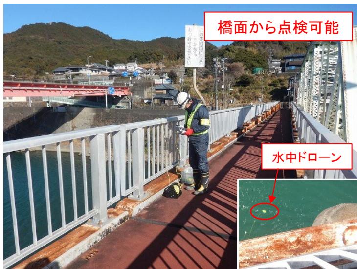
写真-1 点検状況
