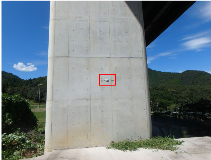
写真-1 点検状況
