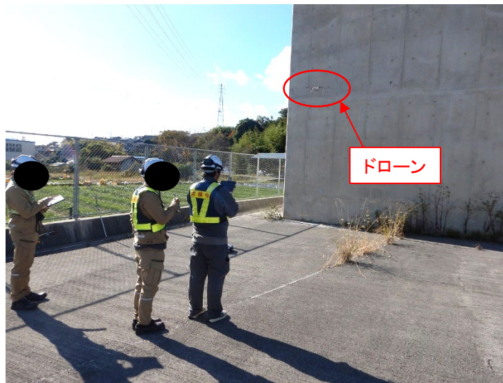
写真-1 点検状況
