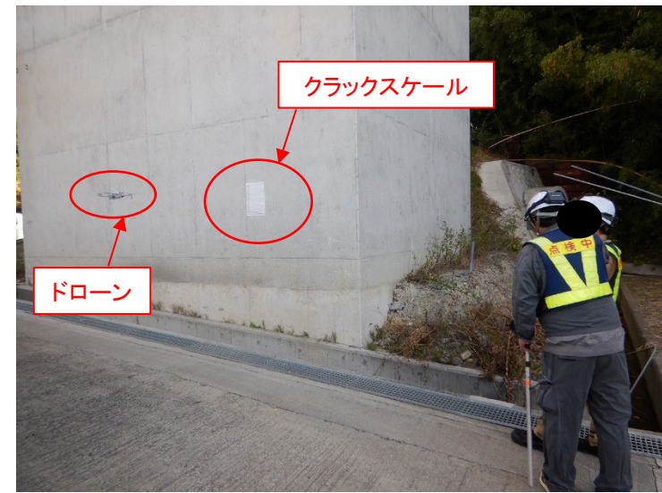
写真-2 キャリブレーション状況
