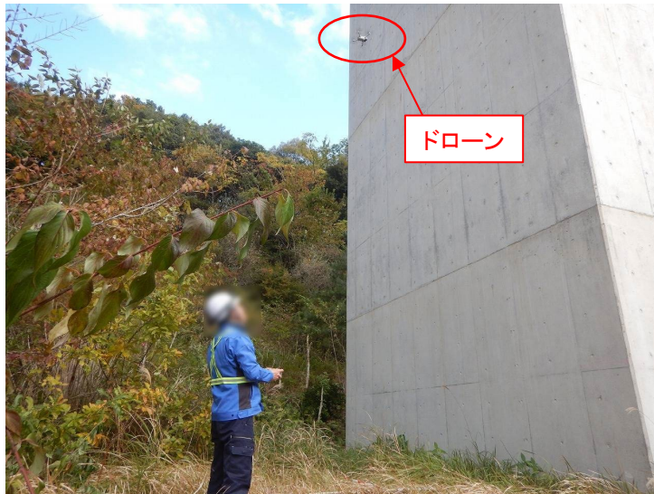
写真-1 点検状況
