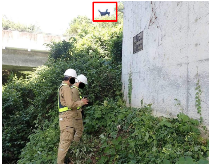
写真-1 ドローンによる撮影状況
