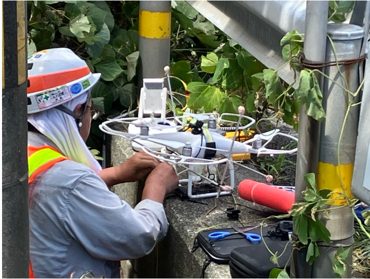
写真-1 点検状況
