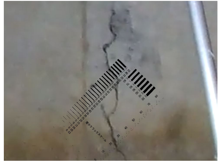
写真-4 縦壁(写真-3の接写)
