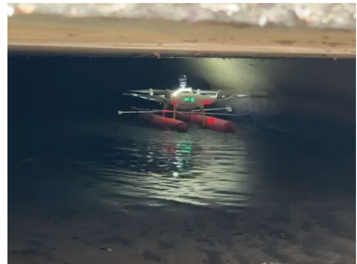
写真-2 ドローン撮影状況
