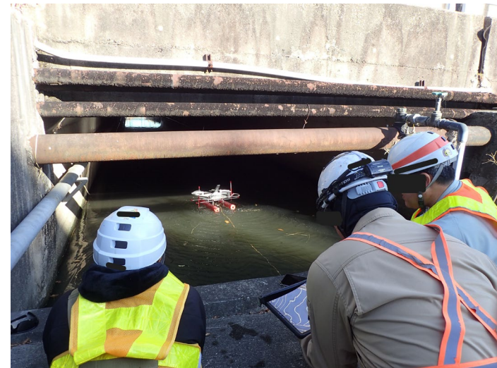
写真-2 点検状況写真
