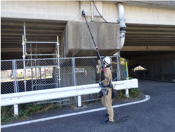
写真-1 点検状況(主桁)
