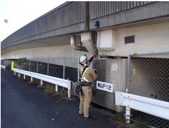
写真-3 点検状況(地覆)
