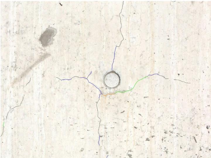
写真-3 損傷写真(ひびわれ)
