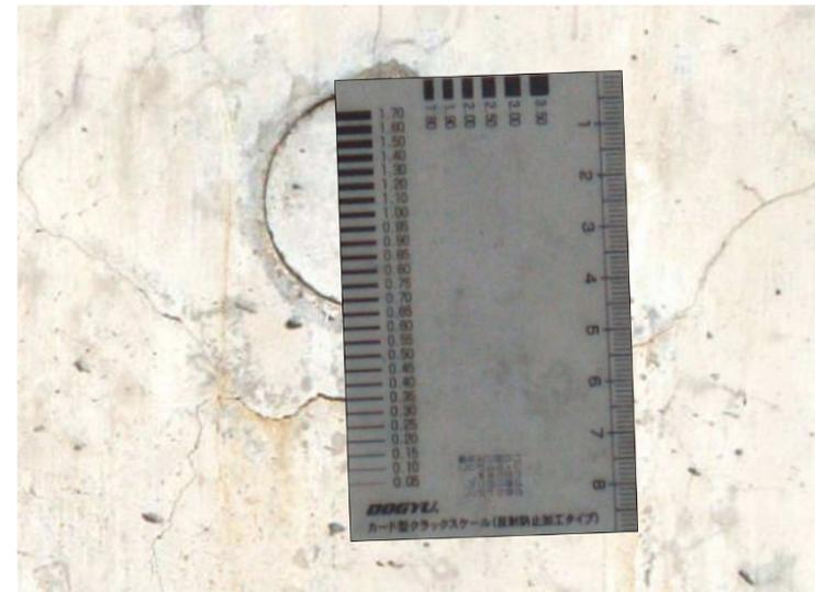
写真-4 ひびわれ幅計測(モニター上)
