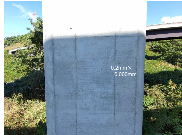
写真-4 柱部・壁部(ひびわれ W=0.2mm:c)
