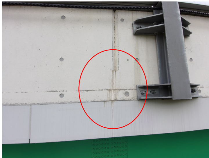
写真-3 損傷写真(ひびわれ、漏水・遊離石灰)
