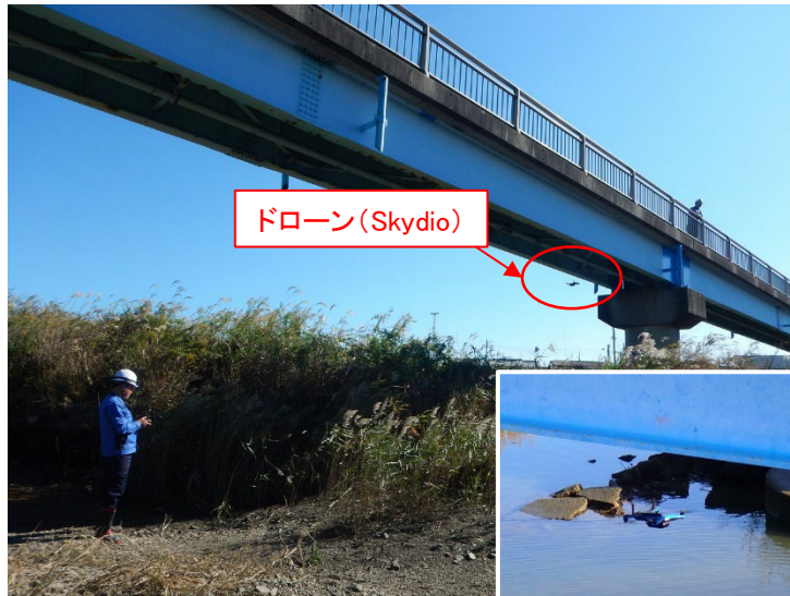
写真-1 点検状況
