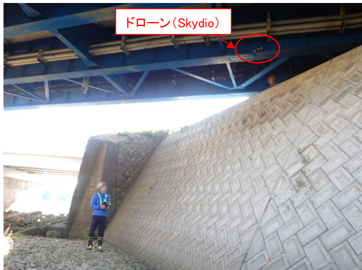
写真-1 点検状況
