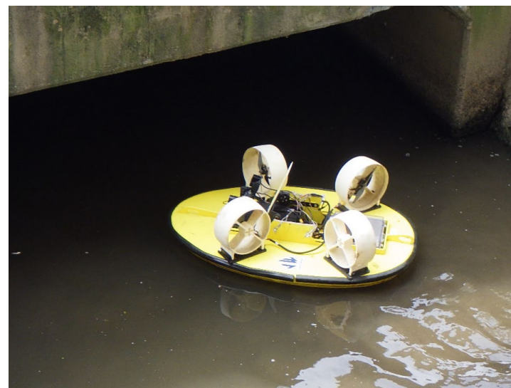
写真-2 ドローン点検状況
