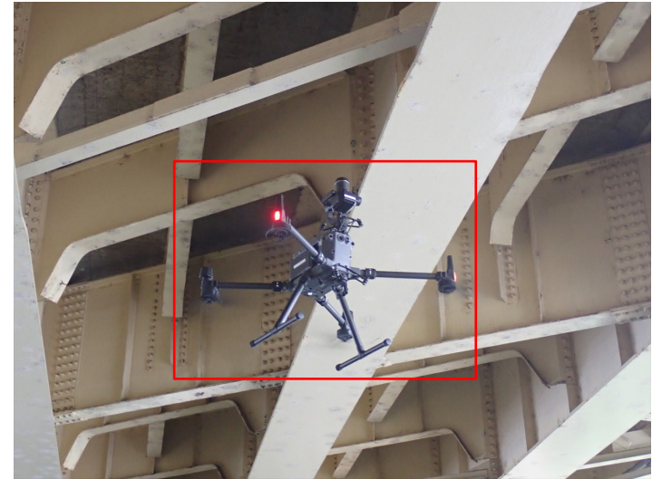
写真-2 点検状況
