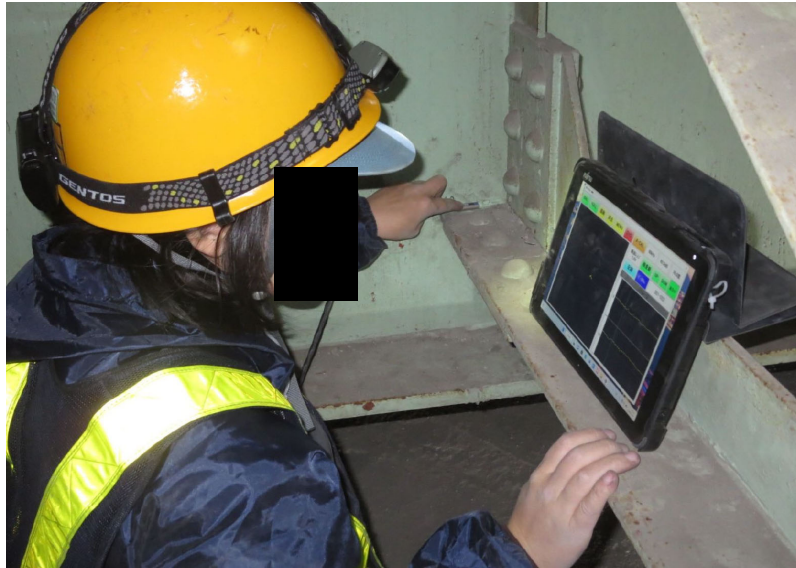
写真-1 調査状況
