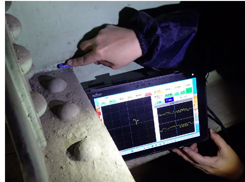
写真-2 調査状況
