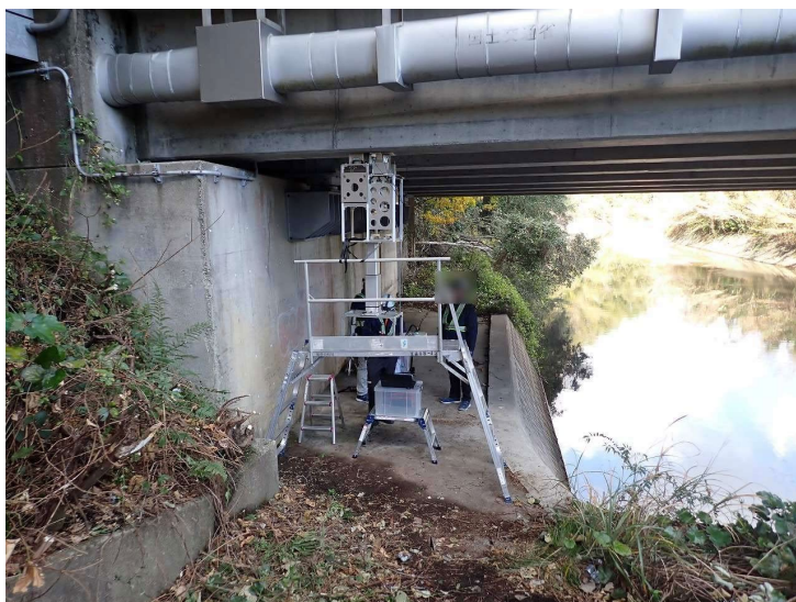
写真-1 設置状況
