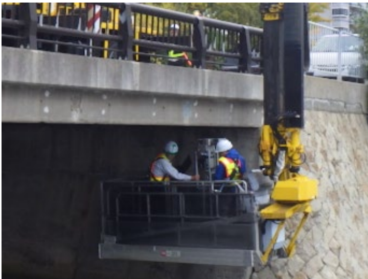
写真-1 設置状況(全景)
