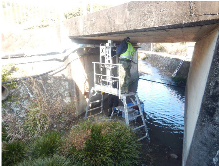
写真-1 設置状況
