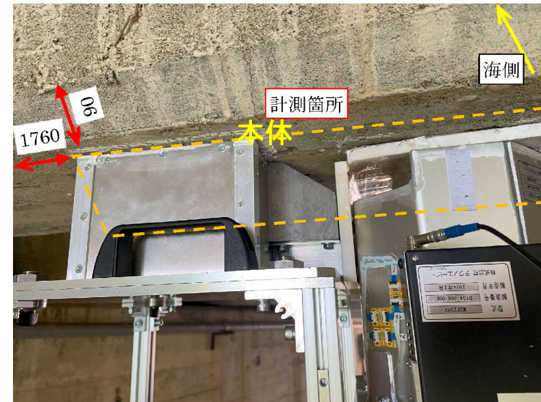
写真-2 計測箇所
