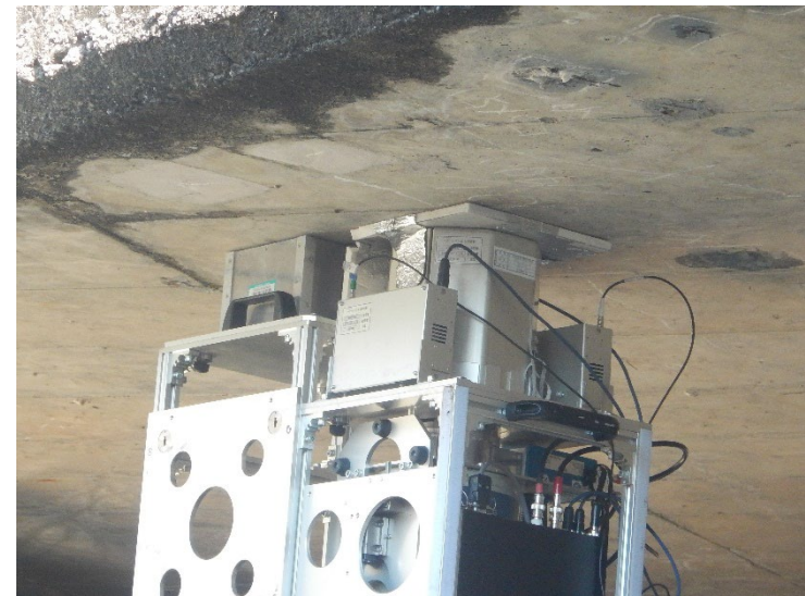
写真-2 計測箇所
