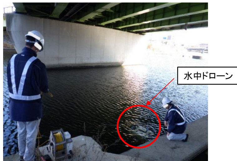
写真-1 ドローンによる点検状況
