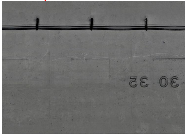
写真-3 画像展開図(目地部閉合ひび割れ)
