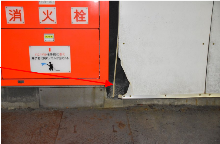
内装板の破損の確認
