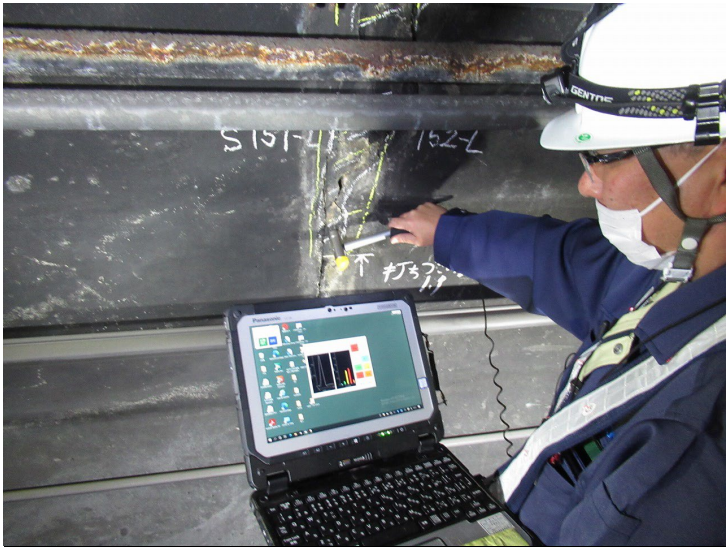
写真-2 計測状況(アーチ部)
