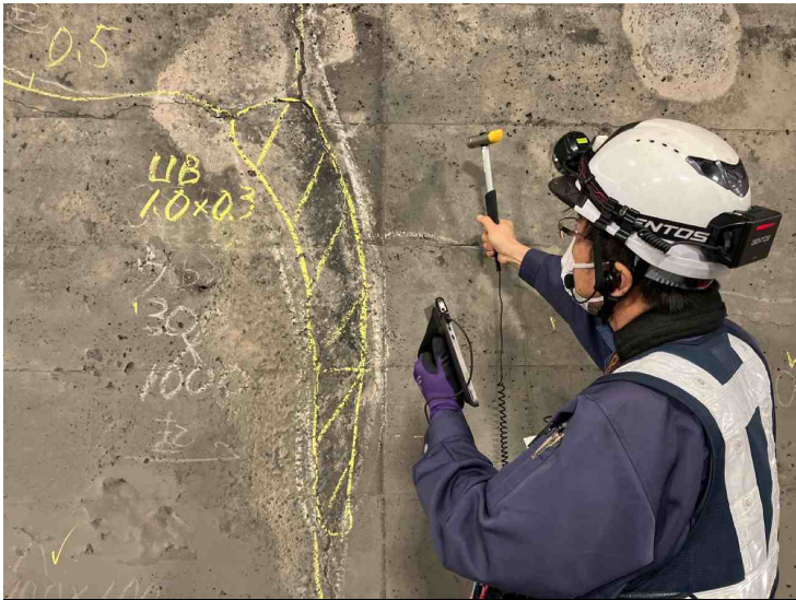
写真-2 計測状況(側壁部)
