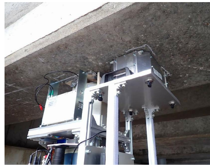
写真-2 計測箇所
