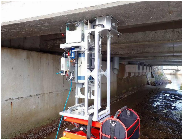
写真-1 設置状況
