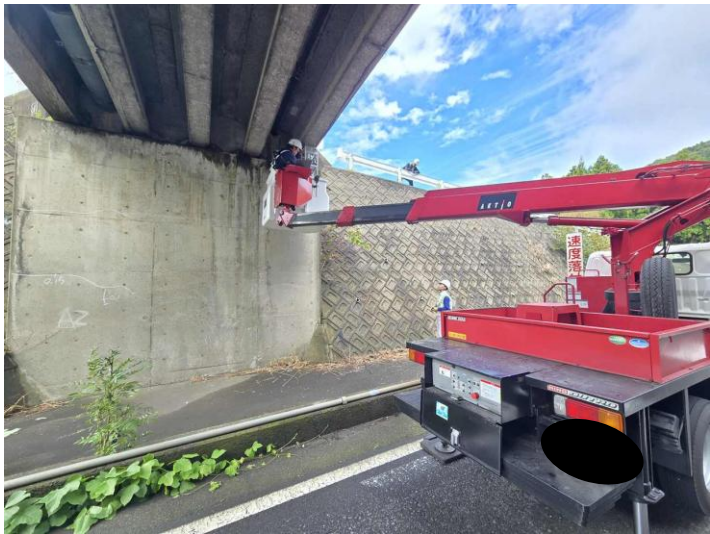
写真-1 調査状況
