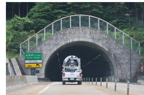
トンネル坑口
