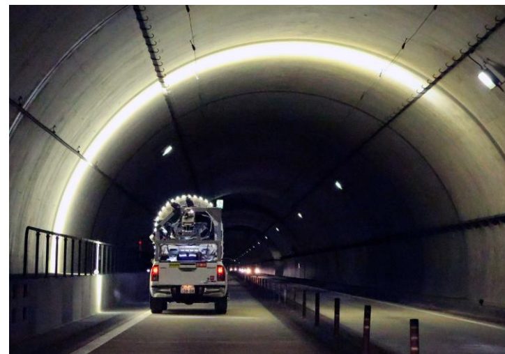
写真-2 計測状況
