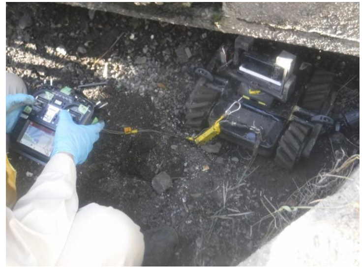
写真-2 水陸両用ロボットによる撮影状況
