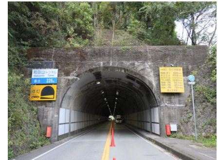
トンネル坑口
