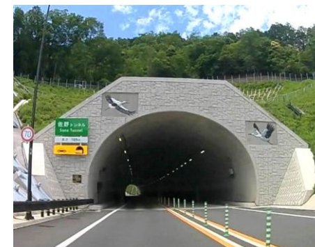
トンネル坑口
