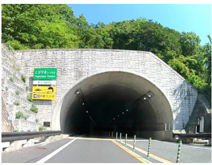
トンネル坑口
