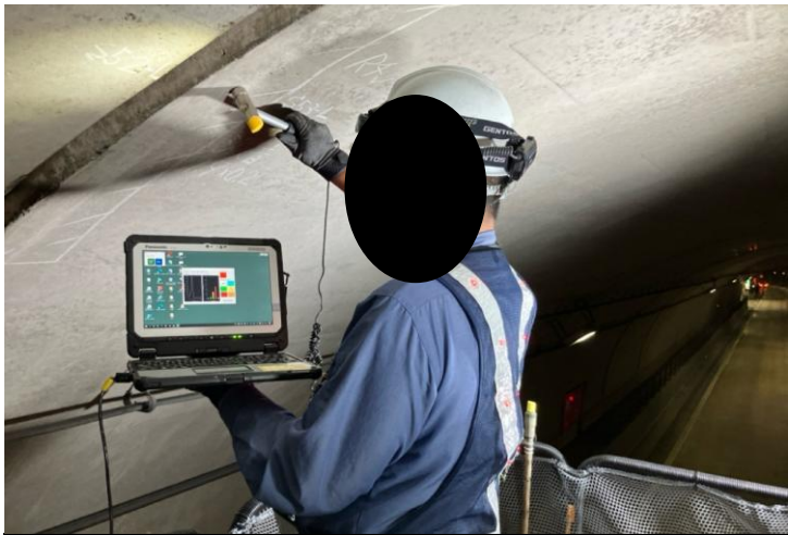
写真-2 計測状況(アーチ部)
