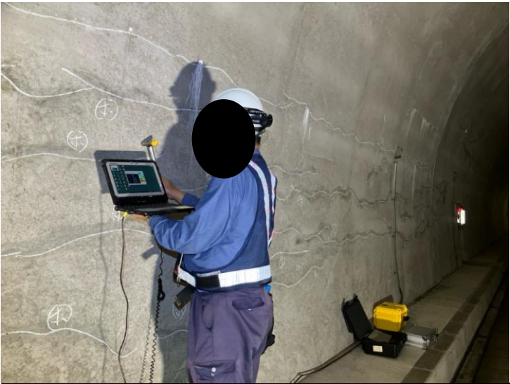
写真-1 計測状況(側壁部)
