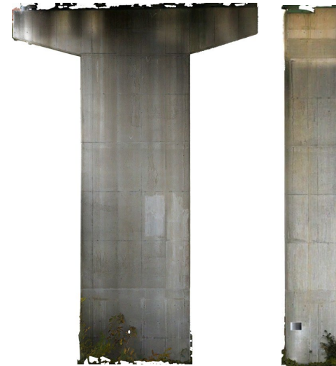
写真-2 撮影画像を合成、オルソ補正
