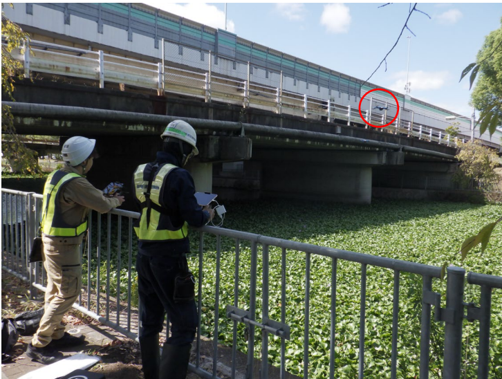
写真-1 ドローン操作状況
