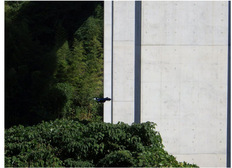
写真-2 ドローン点検状況
