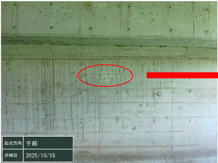
写真-3 P2橋脚(ひびわれ:d)
