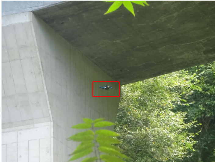
写真-1 点検状況
