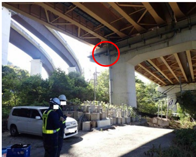
写真-1 点検状況
