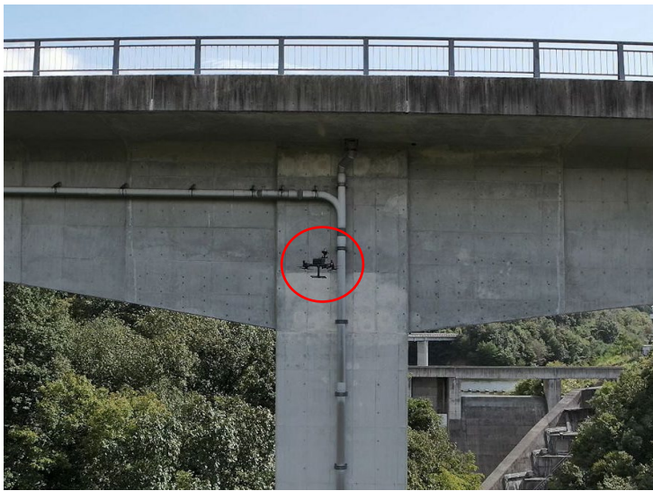
写真-2 ドローン飛行状況
