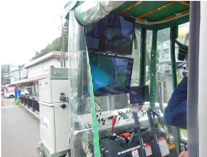
写真-3 機器操作状況
