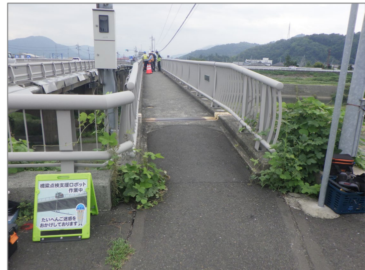
写真-2 交通規制状況
