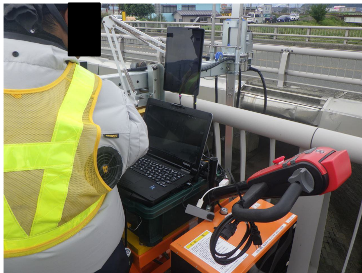
写真-3 操作状況
