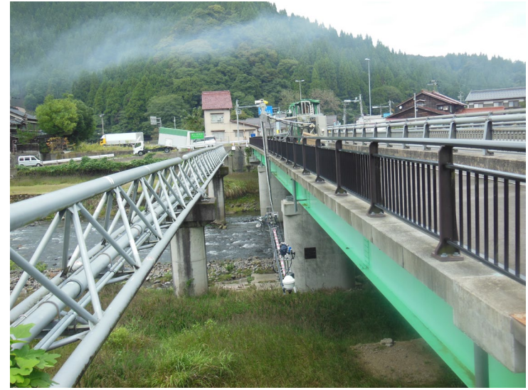
写真-2 点検状況
