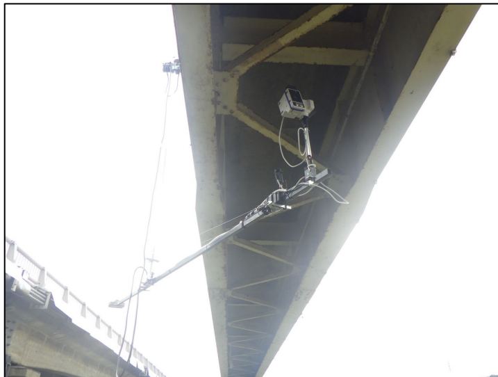
写真-1 点検状況
