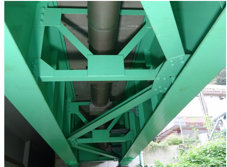
写真-4 主桁（健全）
