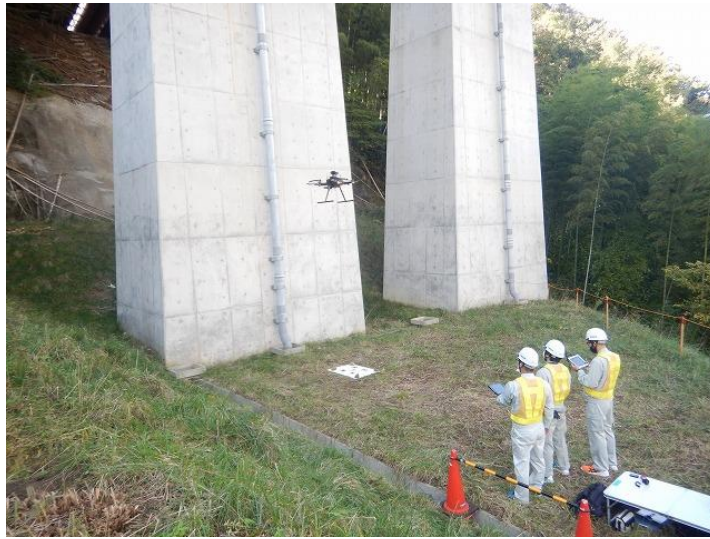
写真-1 点検状況
