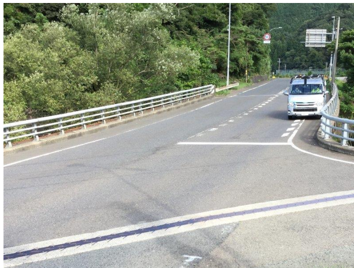
写真-3 点検状況(前方)
