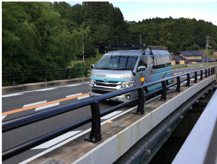
写真-3 点検状況(前方)
