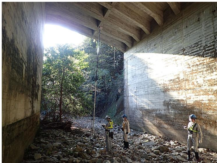
写真-1 点検状況
