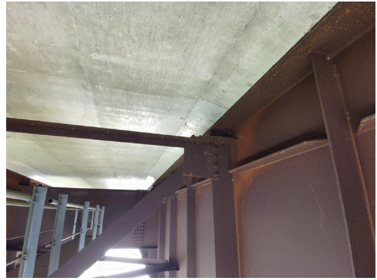
写真-2 対傾構(健全)
