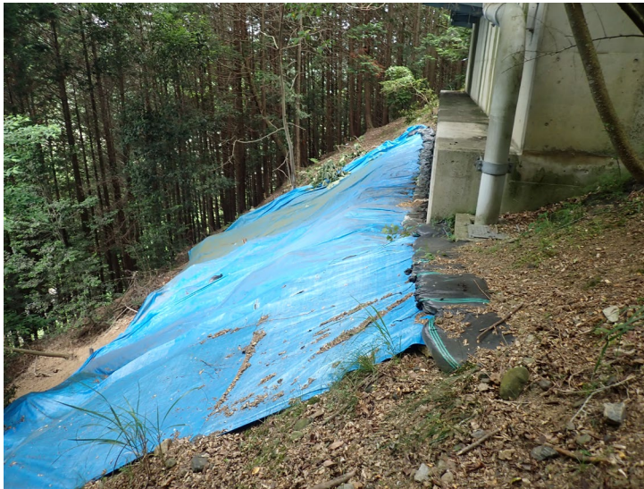
写真-1 現地斜面状況
