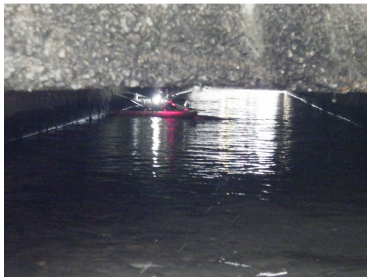
写真-3 溝橋ドローン点検状況
