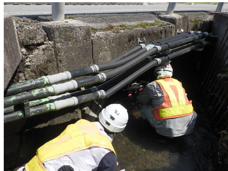
写真-2 溝橋ドローン準備状況
