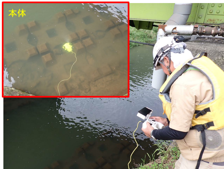
写真-3 点検状況
