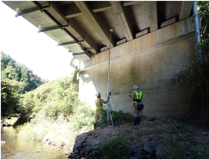
写真-1 点検状況
