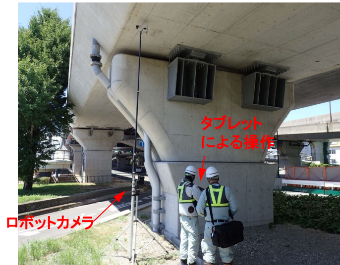
写真-1 点検状況
