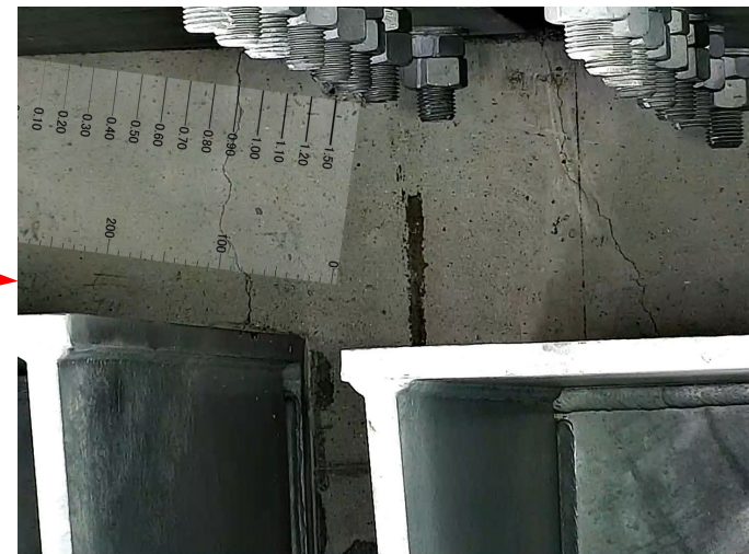
写真-4 橋脚梁部(写真-3の接写)
