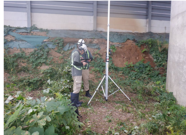
写真-2 ロボットカメラ点検状況
