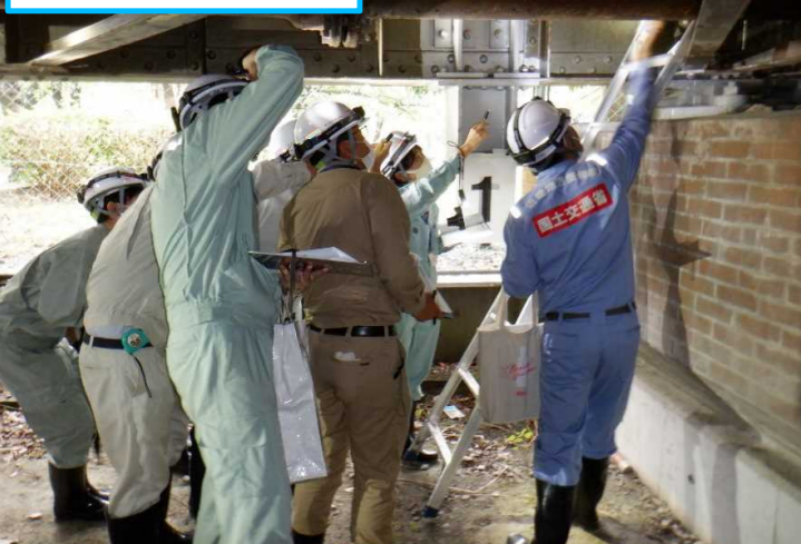
橋梁メンテナンス研修
