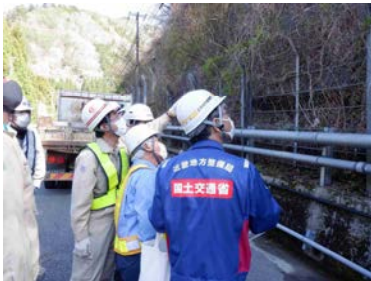
R29 宍粟市波賀町 自然斜面落石
