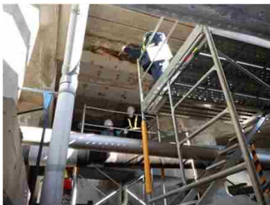
桁下面の打音及び板厚調査 (特殊床板部)
