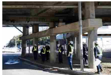
桁下・橋脚目視調査
