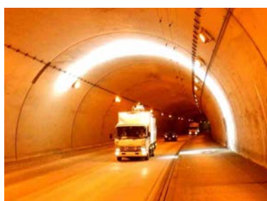
走行型計測車両 (国道27号 和知トンネル:京都府京丹波町)
