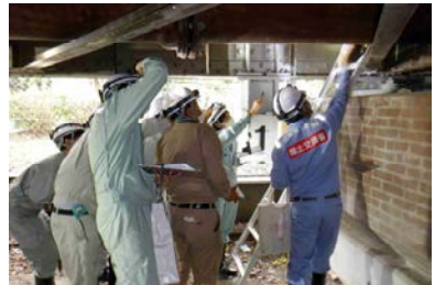
自治体職員への橋梁点検方法について説明 (国道1号 桜宮橋：大阪府大阪市)
