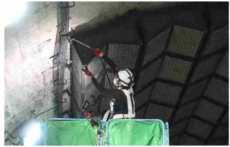
トンネル打診点検 (国道158号 越坂トンネル：福井県永平寺町) (福井河川国道事務所提供)
