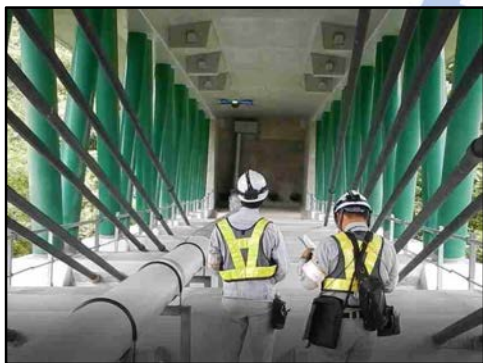
ドローンによる橋梁上部工の点検 国道42号木ノ川高架橋（和歌山県新宮市）
