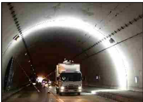
走行型計測車両によるトンネルの点検 国道27号和知トンネル（京都府京丹波町）
