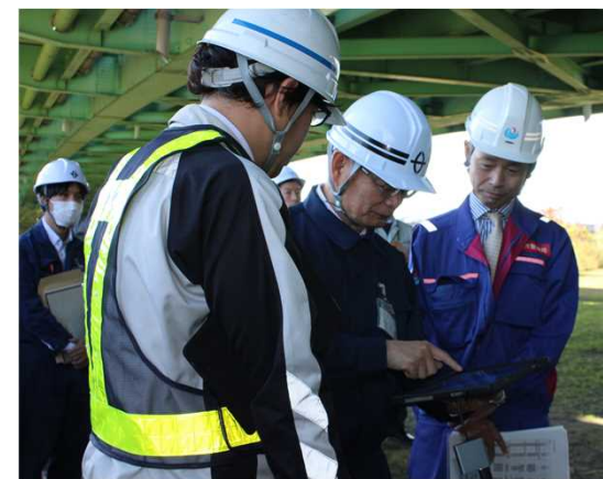
橋梁等構造物の点検ロボットカメラ
