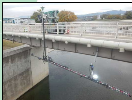
橋梁点検支援ロボット「視る・診る」による 橋梁上部工の点検 国道1号鳥羽大橋側道橋（京都府京都市）
