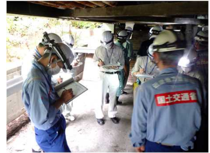
橋梁メンテナンス研修（初級 I 現場研修）
