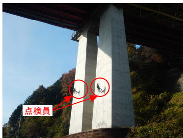
ロープアクセスによる点検 (国道25号中畑橋:奈良県奈良市)
