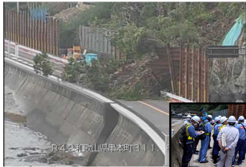
国道42号 和歌山県串本町：法面崩落
