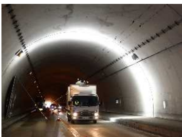
走行型計測車両による点検 (国道27号和知トンネル:京都府船井郡京丹波町)
