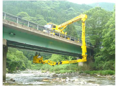
橋梁点検車による点検 (国道29号 有賀大橋：兵庫県宍粟市)
