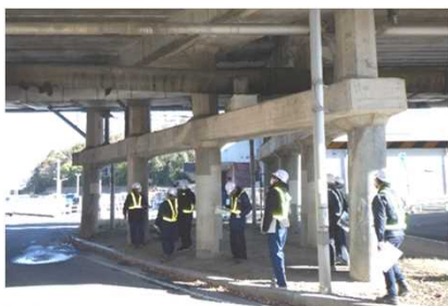
桁下・橋脚目視調査
