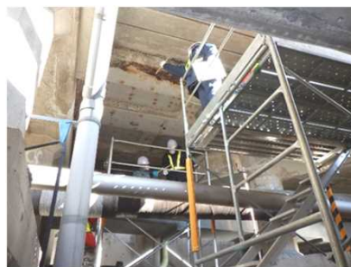
桁下面の打音及び板厚調査 (特殊床板部)
