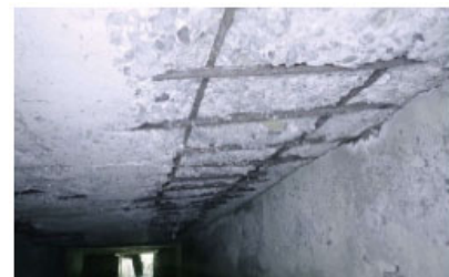
<頂版の鉄筋露出>
