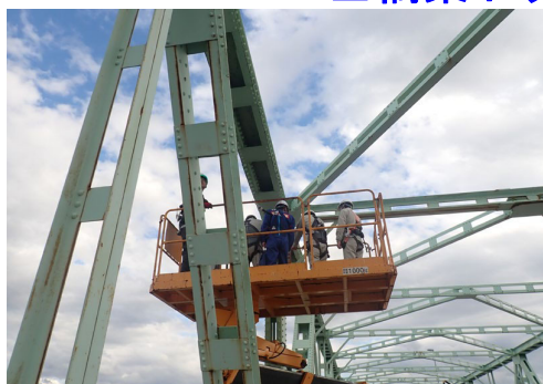
橋梁ドクター現地確認 (国道42号 和歌山県 新宮市)
