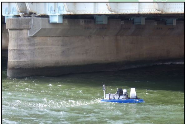
全方向水面移動式ボート型ドローンによる 洗掘状況の計測 国道2号淀川大橋（大阪府大阪市）
