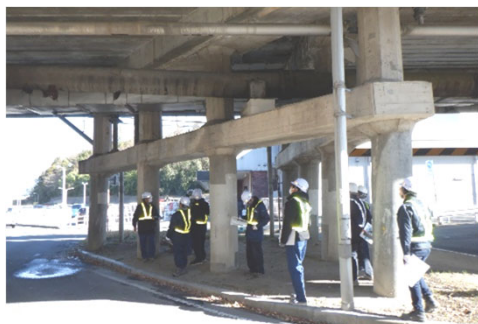
桁下・橋脚目視調査
