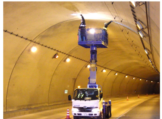
トンネル打音点検 （国道9号 和知トンネル: 京都府京丹波町）
