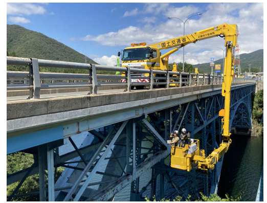
橋梁点検車による点検 マスターパン (国道27号 升谷橋: 京都府船井郡京丹波町)
