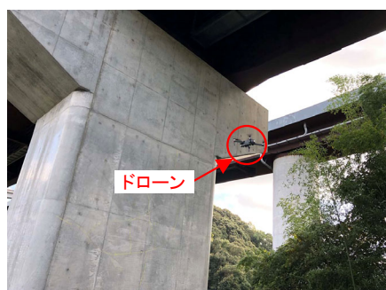
ドローンによる点検 (国道24号大野第二高架橋: 和歌山県橋本市)
