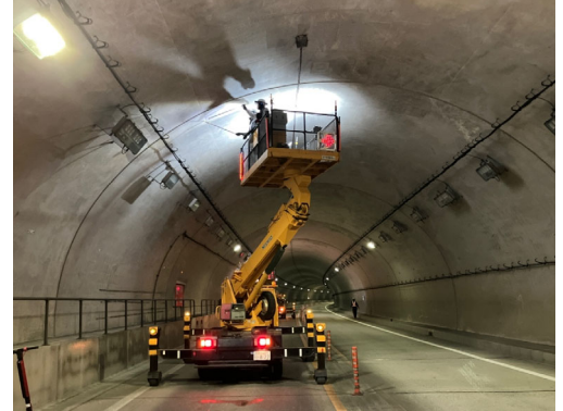
トンネル打音点検 (国道483号 三谷トンネル:兵庫県養父市)
