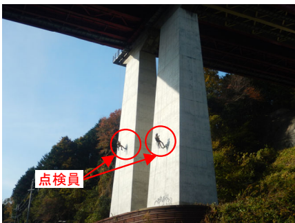
ロープアクセスによる点検 (国道25号中畑橋:奈良県奈良市)
