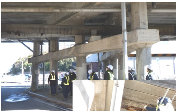
桁下・橋脚目視調査
