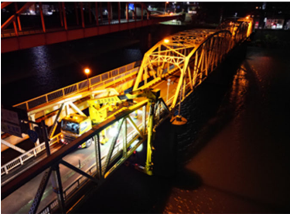
橋梁点検車(BT-400)による橋梁の点検 国道42号熊野大橋(和歌山県新宮市)
