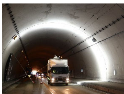
走行型計測車両による点検 (国道27号和知トンネル:京都府船井郡京丹波町)
