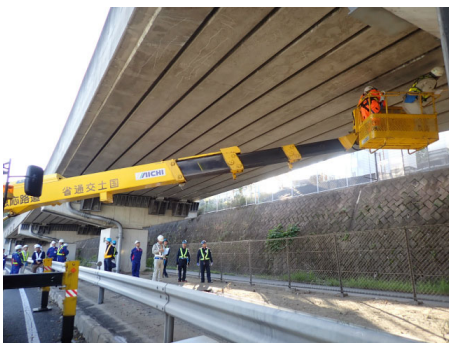
橋梁ドクター現地確認 (国道24号 奈良県 奈良市)
