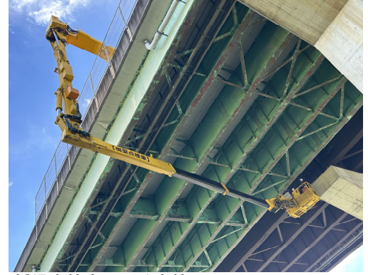
橋梁点検車による点検 (国道175号 山田高架橋(上):兵庫県小野市)
