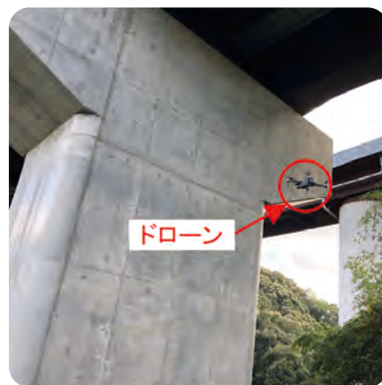
ドローンによる点検
