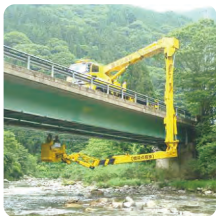
橋梁点検車による点検
