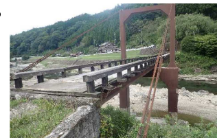
木製吊り橋の現況
