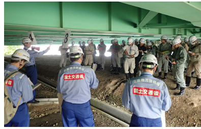
自治体職員への橋梁点検方法について説明 (国道1号 新池副道橋：滋賀県草津市)
