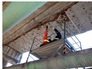
橋梁梁コンクリート鉄筋探査、強度確認
