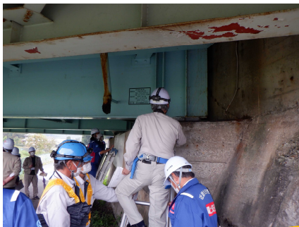
橋梁ドクター現地確認 (国道9号 和田大橋 ：福知山)
