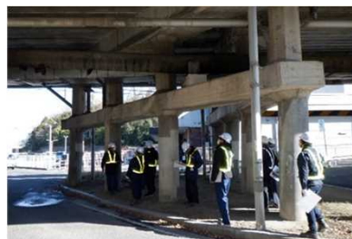
桁下・橋脚目視調査
