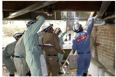
自治体職員への橋梁点検方法について説明 (国道1号 桜宮橋：大阪府大阪市)
