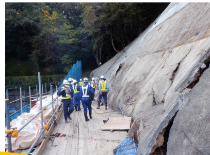
防災ドクター現地確認 (国道27号 加斗地区 法面：福井)
