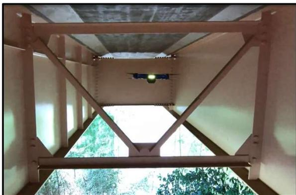
小型ドローンによる橋梁上部工の点検
