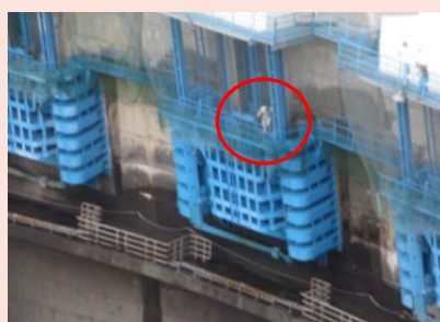
ダム放流設備（ゲート）の点検
