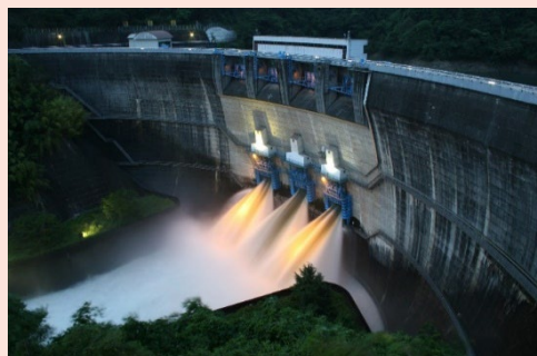
ダム放流設備（ゲート）からの放流
