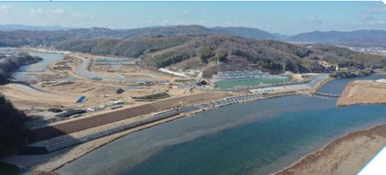
平成30年7月豪雨では、高梁川水系小田川沿川の岡山県倉敷市真備町において、堤防の決壊や越水などが発生し、広範囲に家屋が浸水するなど甚大な被害が発生しました。このため、岡山県及び倉敷市と連携し、再度災害防止を図るべく、「真備緊急治水対策プロジェクト」として、小田川合流点付替え事業や「マイ・タイムライン」の作成支援などハード・ソフト対策を重点的に実施しています。
