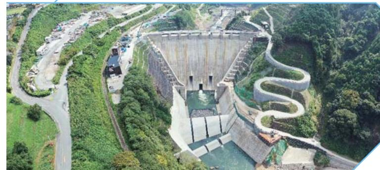
立野ダムは、白川沿川の洪水被害を防ぐことを目的とした洪水調節専用ダム(流水型ダム)で、昭和28年6月の洪水と同程度の洪水を安全に流すことを目指しています。下流において洪水時のピーク流量を低減させ、洪水被害の防止、軽減を図ります。またピーク流量の発生時間を遅らせることで、避難する時間を長く確保することができます。
