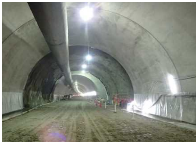
写真：水泥トンネル建設現場
