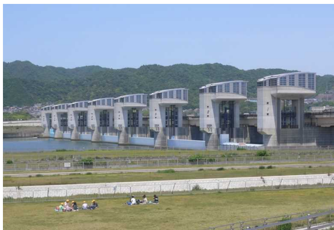
写真：紀の川大堰
