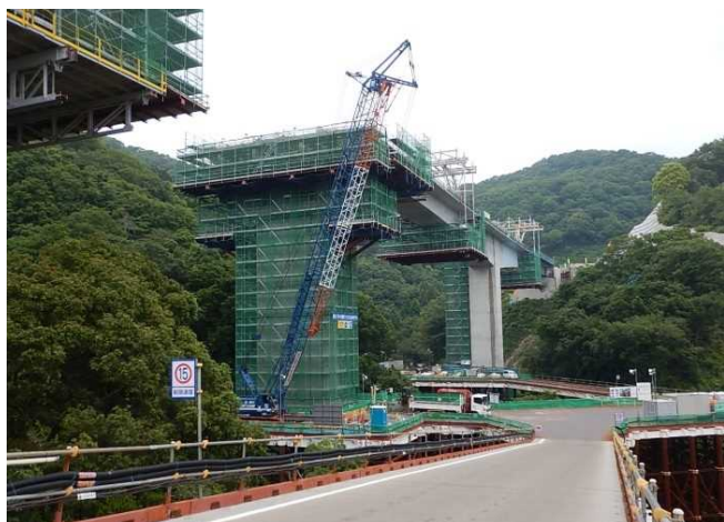
写真：紀北西道路 雄ノ山高架橋建設現場
